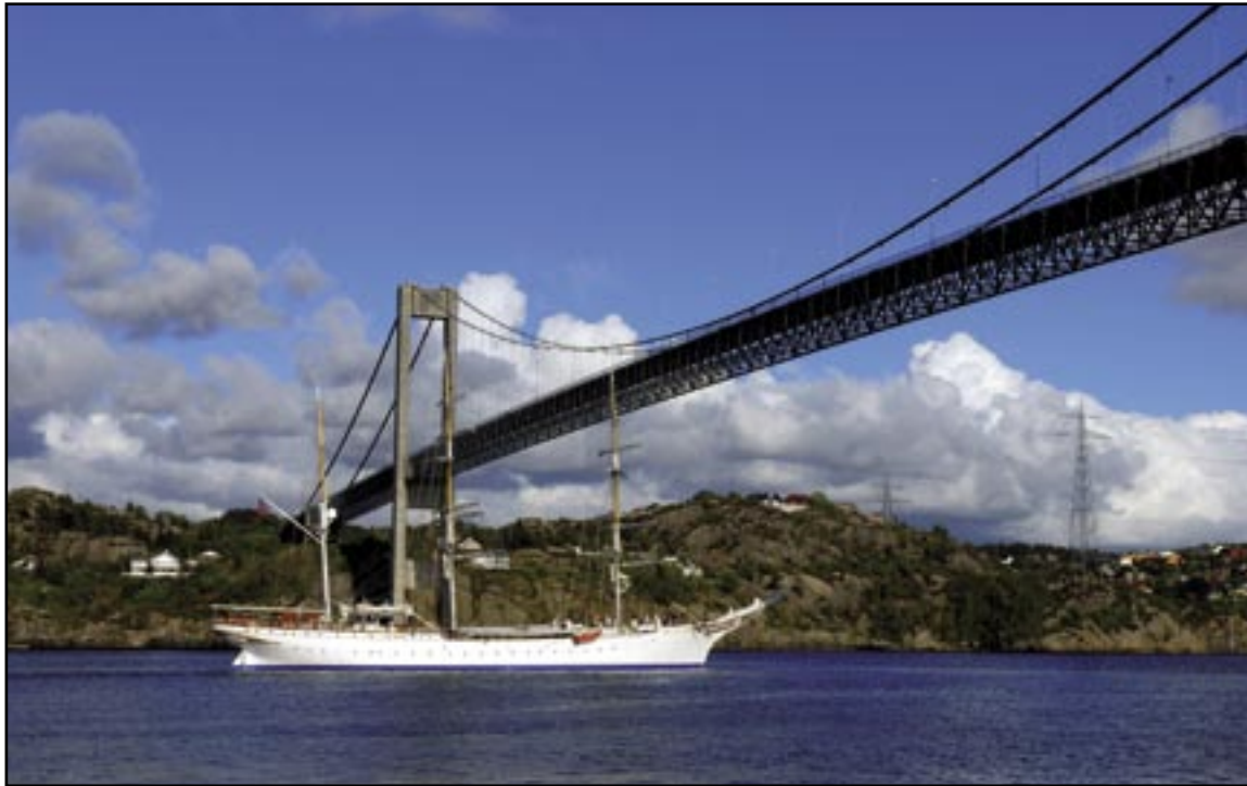
Etter åpningen av Sotrabroen i 1971, ble kommunikasjonen mellom øyriket og Bergen dramatisk forbedret. Med en lengde på 1236 m, var broen den lengste i landet da den åpnet.
