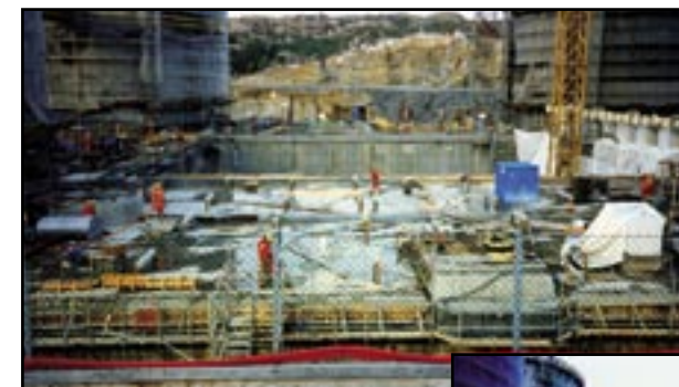
Til høyre: Konstruksjon i betong og stål
